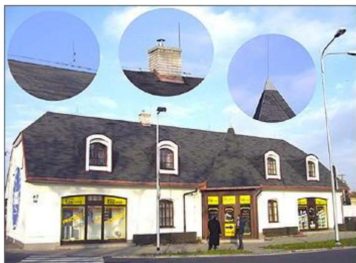
На приведенных фотографиях показан дом, система молниезащиты которого выполнена в виде так называемой молниеприемной сетки. Так как здание имеет усложненную архитектуру, помимо сетки на выступающих элементах конструкции крыши устанавливаются дополнительные штыревые вертикальные молниеприемники, которые должны обеспечить увеличение зоны защиты от прямого удара молнии.
